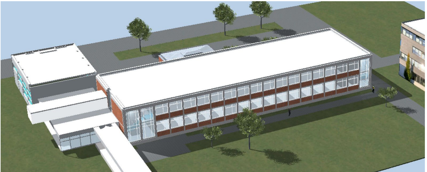
Bild: Architekt Fritsch
